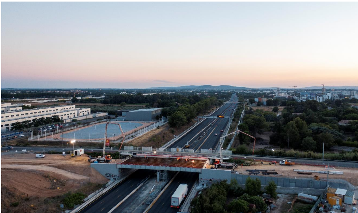
Bétonnage du tablier du futur pont. (photo : Fliparts)
