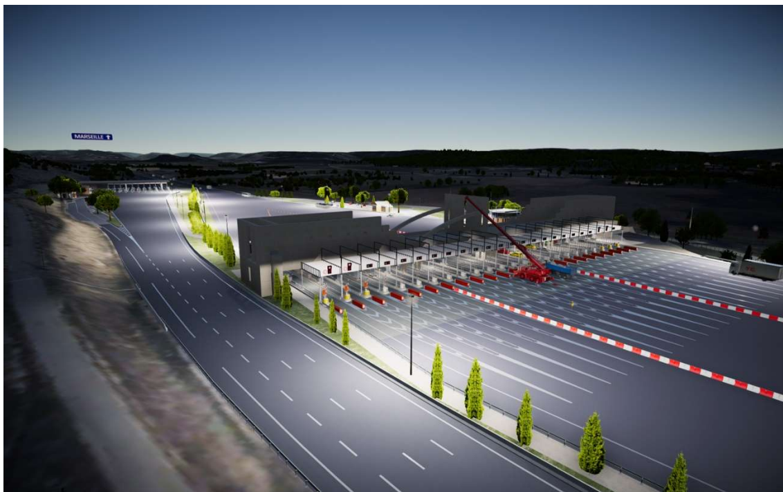
Vue de la barrière de péage de Lançon-Provence pendant les travaux (image 3D non contractuelle)
