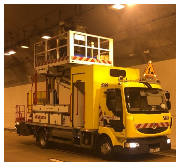
Vérification et remplacement de l'éclairage
