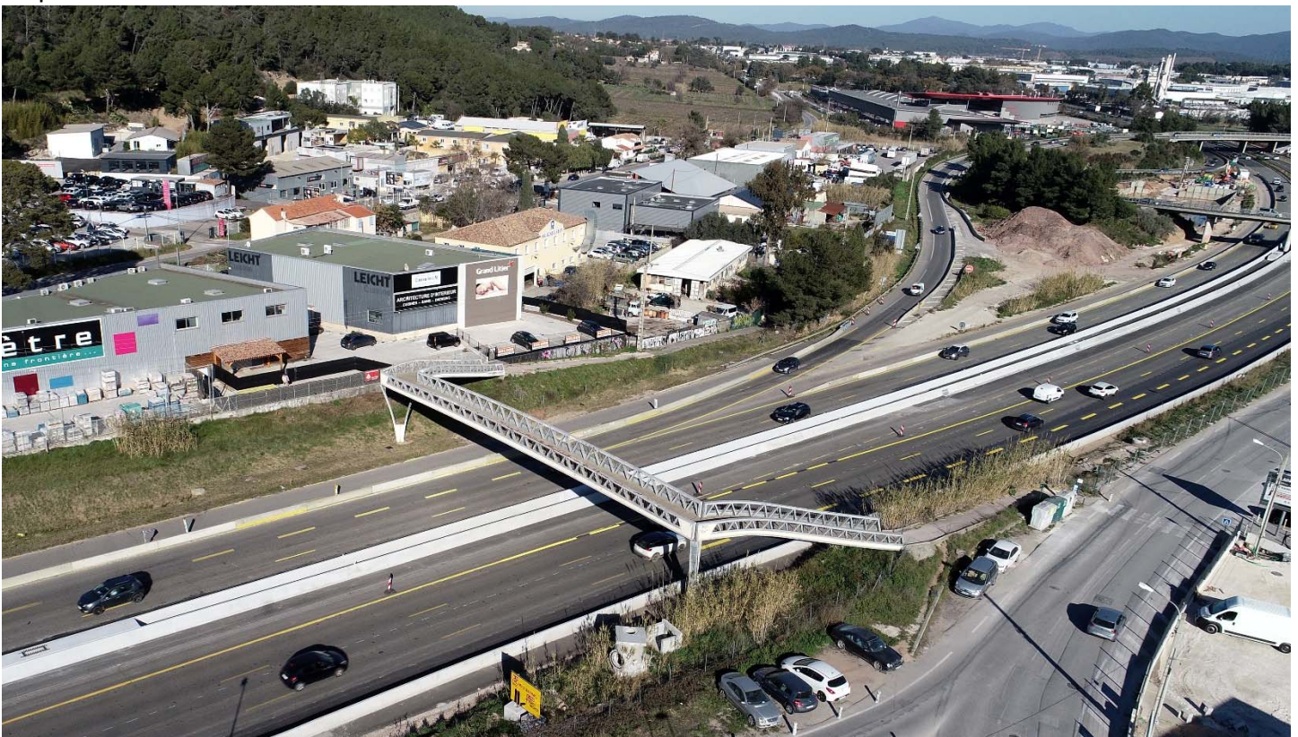
La passerelle piétonne de Pierre Ronde enjambe les deux sens de circulation de l'autoroute A57 non loin de la bifurcation A57/A570. (Crédit photo Elite Drone)
