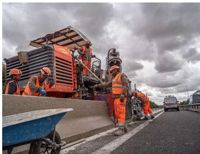
Remplacement du terre-plein central
