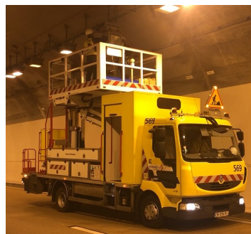
Vérification et remplacement de l'éclairage
