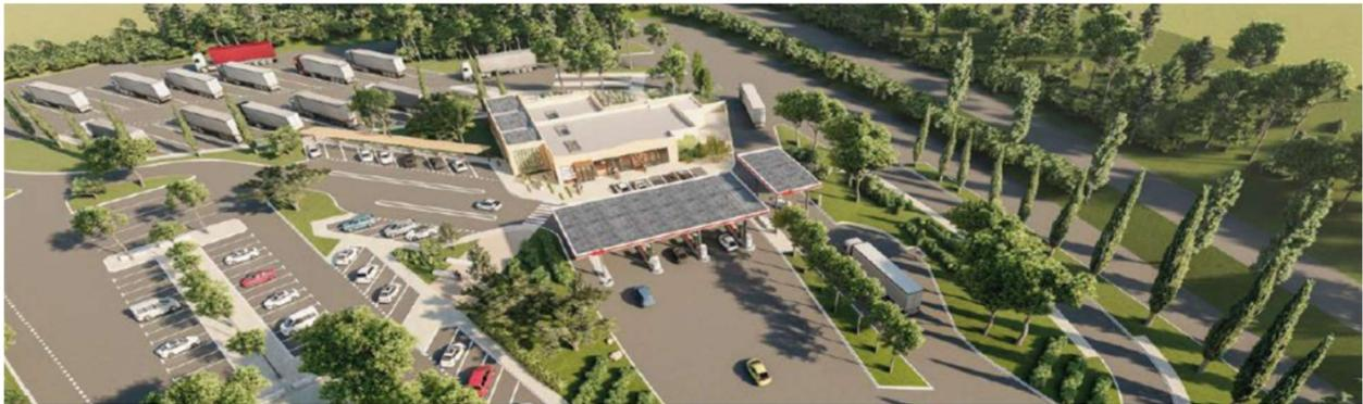
Projet des modules photovoltaïques sur les auvents et bâtiment de l'aire des Corbières sud.
