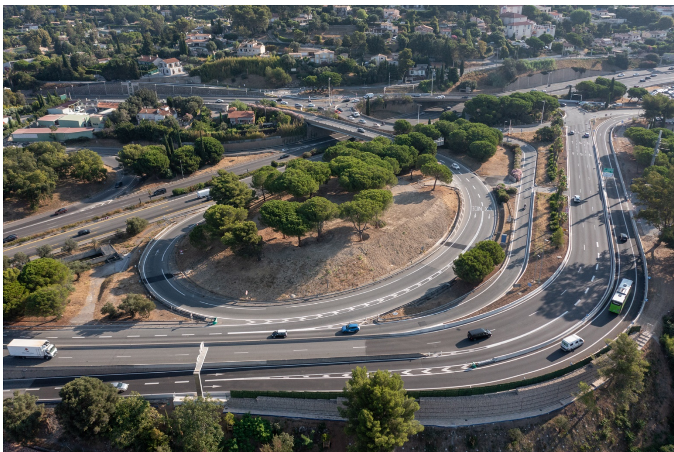
Elargissement de la bretelle de sortie et création d'une nouvelle voie dédiée vers Cannes / Le Cannet par un mur de soutènement - Crédits photos : Film For Change
