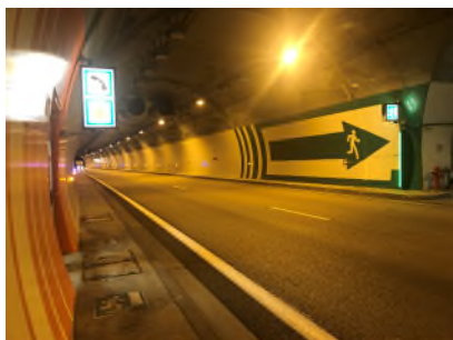
Maintenance dans les trois tunnels
