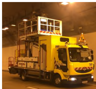
Vérification et remplacement de l'éclairage
