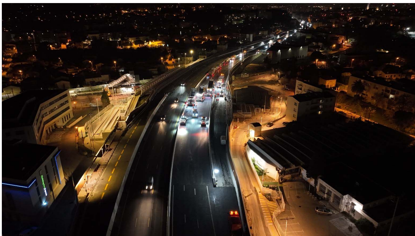
Application des enrobés définitifs sur les chaussées de l'A57 dans le sens Nice-Toulon, week-end du 14 au 17 février © Elite drone
