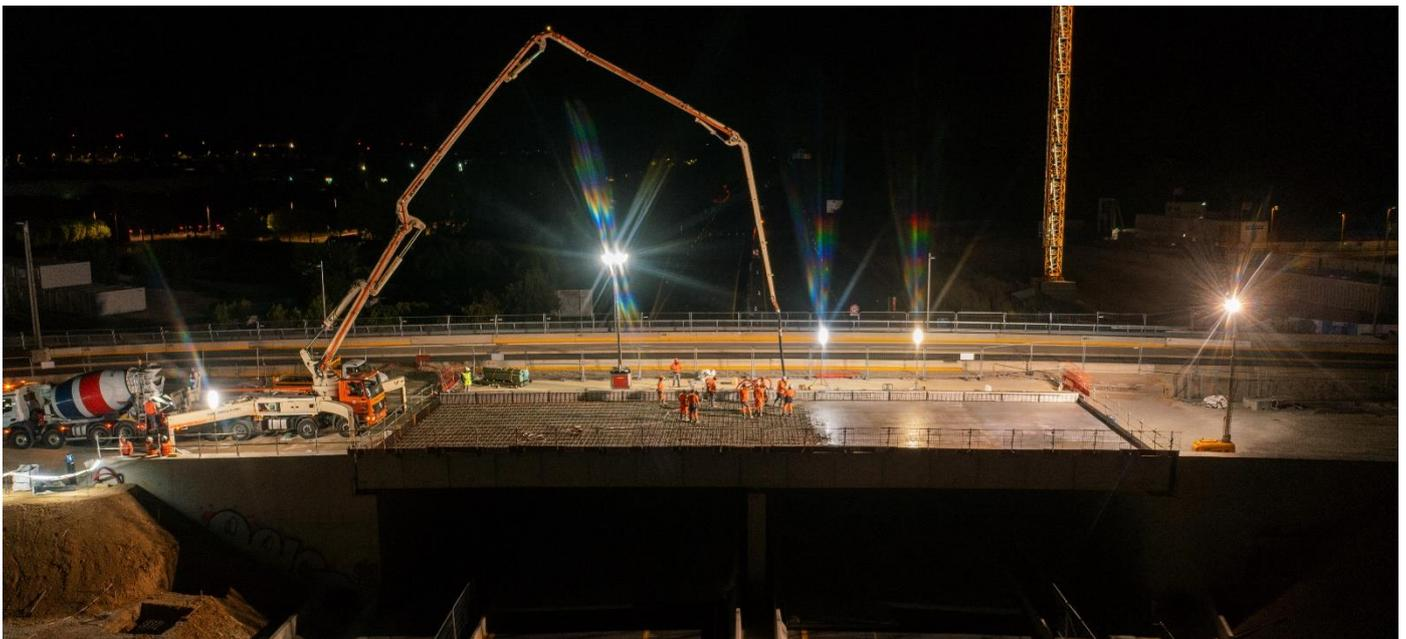
2<sup>ème</sup> phase du bétonnage du tablier du futur pont. (Photo : Fliparts)
