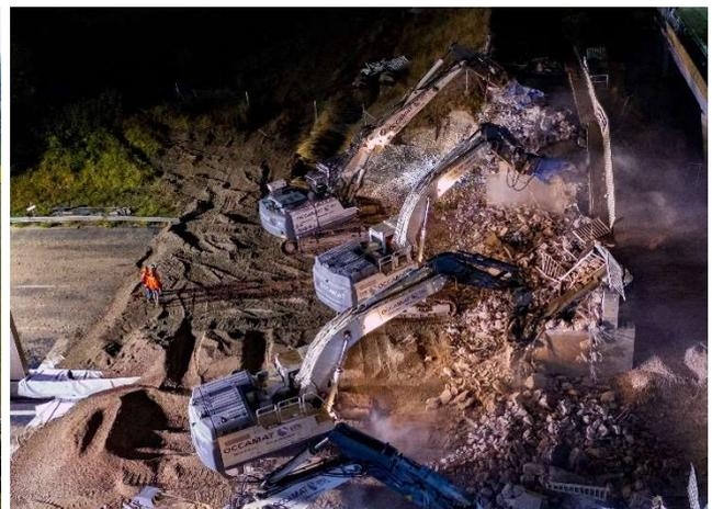
**En mai 2021, deux opérations fondamentales se déroulent sur le chantier d’aménagement de l’autoroute A10 au nord d’Orléans : le second lancement de la charpente de l’ouvrage saut-de-mouton et la déconstruction du 8<sup>ème</sup> et dernier ouvrage d’art du tracé. Ces travaux se dérouleront sous fermetures des autoroutes A10 et A71, les nuits des mardi 25 et mercredi 26 mai 2021.**
