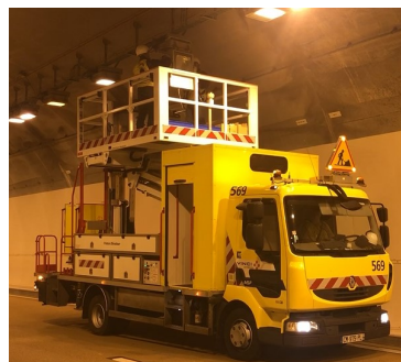
Vérification et remplacement de l'éclairage
