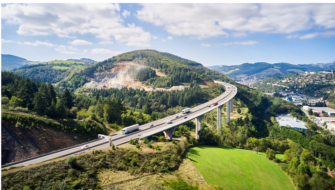
A89 : Le viaduc de Goutte Vignole dans le Rhône. Crédits photo : photothèque VINCI Autoroutes, JP Moulet
