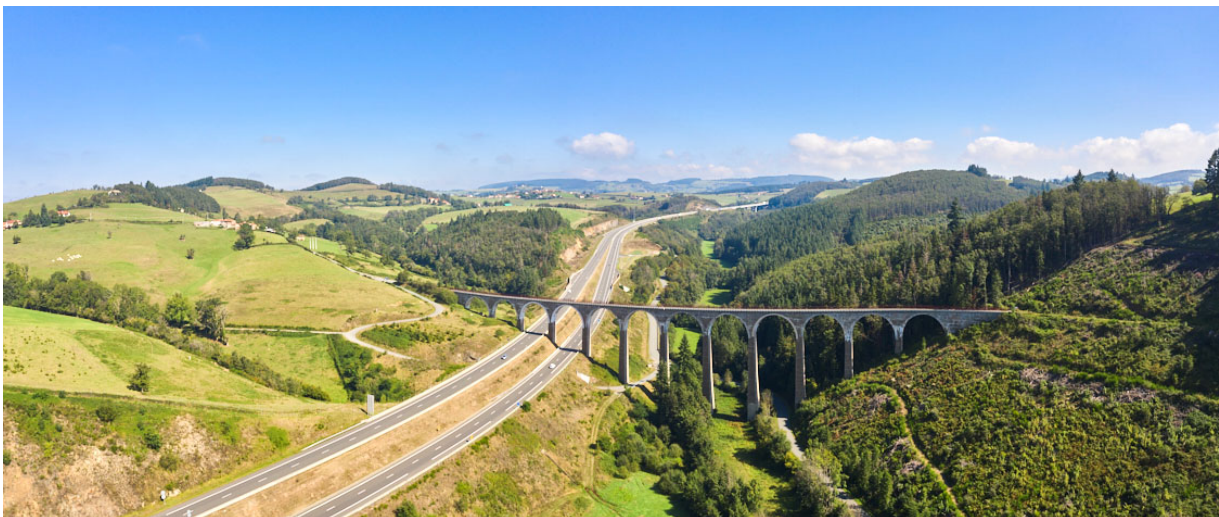
L'A89 dans la Loire passe sous les arches du Pont Marteau- Crédits photo : photothèque VINCI Autoroutes, JP Moulet
