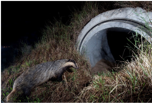
Ecoduc, Crédits photo : Emmanuel Rondeau pour VINCI Autoroutes
