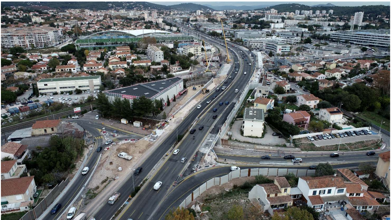
Elargissement A57 dans les secteurs de La Palasse et de Sainte-Musse : Photo Elite Drone
