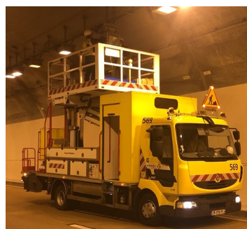
Vérification et remplacement de l'éclairage
