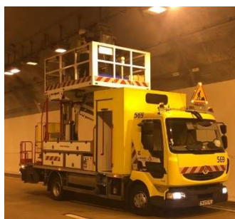
Vérification et remplacement de l'éclairage
