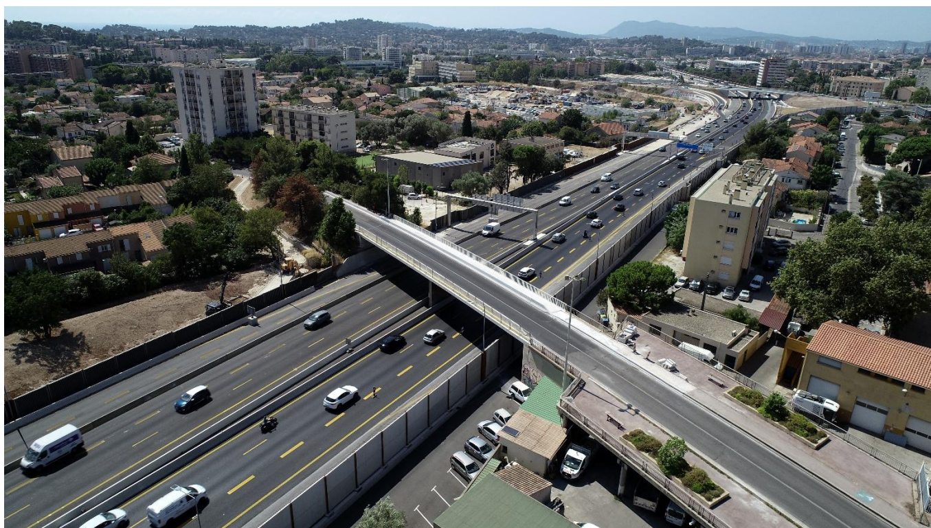
A57 – Secteur du pont de la Coupiane © Elite Drone – Août 2024
