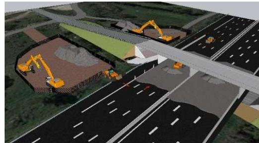
**2.** Les 4 grignoteuses entrent en action pour l'opération « Grignotage du tablier » (la partie supérieure du pont). 2 pelles cisaille équipées de brise roche hydraulique complètent le dispositif.
