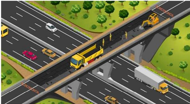
Dépose de la structure d'étanchéité existante
