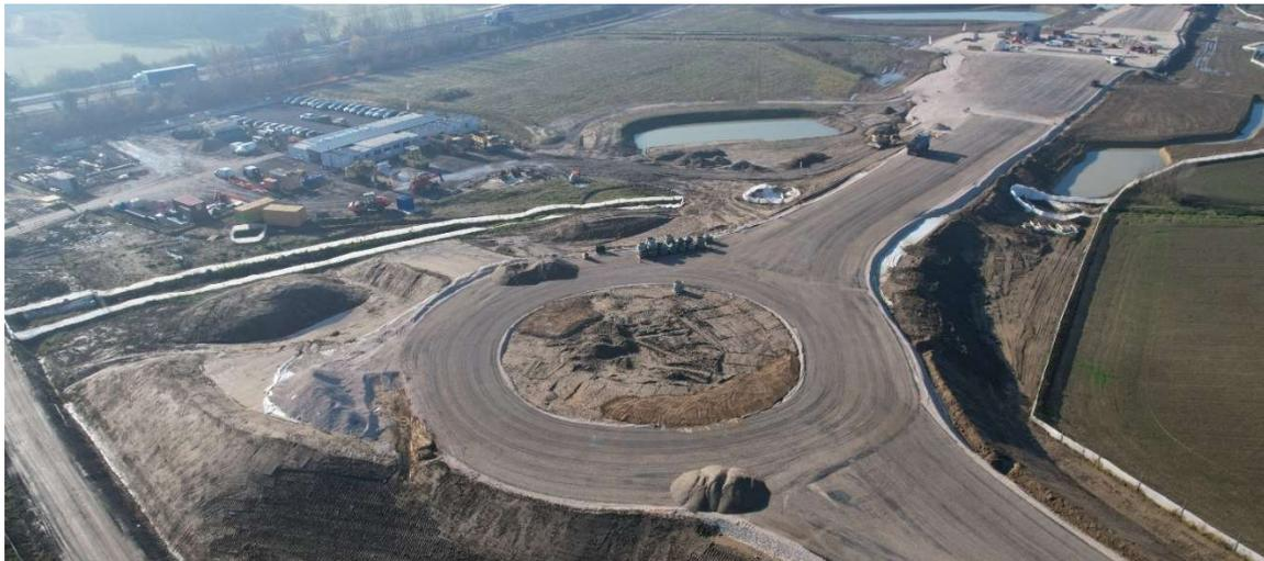
Sur l'A62, VINCI Autoroutes poursuit les travaux du futur échangeur d'Agen-Ouest, avec pour objectif une mise en service fin 2022. Cet aménagement prend concrètement forme et les équipes en charge du chantier vont conduire ces prochains jours des étapes clés de finalisation de la construction du nouvel ouvrage franchissant l'autoroute et d'embranchement entre le nouveau giratoire situé à la sortie de l'échangeur et la route départementale 292.
