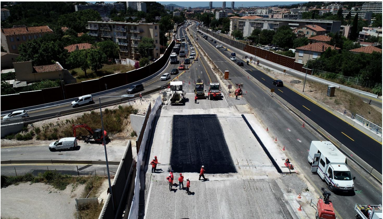
Élargissement A57 – Opération « coup de poing » : réalisation de l'étanchéité du pont de La Palasse © Elite Drone – 16 juin 2024
