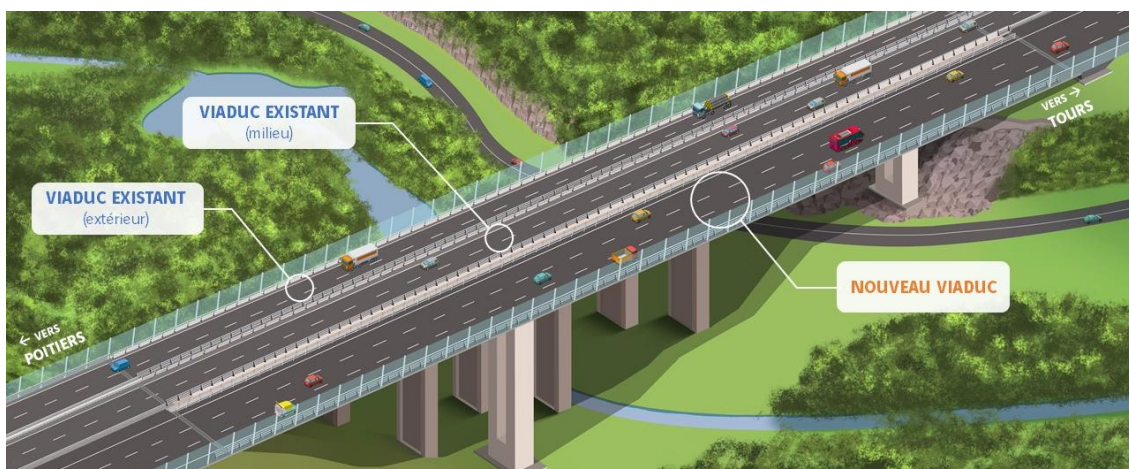
VIADUCS DU COURTINEAU
