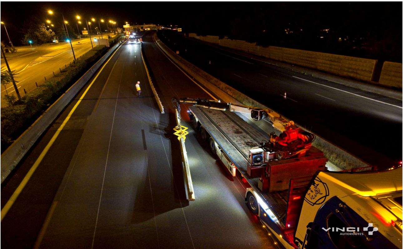
La mise en place du chantier consiste notamment à installer des murets en béton afin de délimiter le basculement à 2 x 2 voies de circulation. Photo : ©VINCI Autoroutes / Guillaume Souvant.
