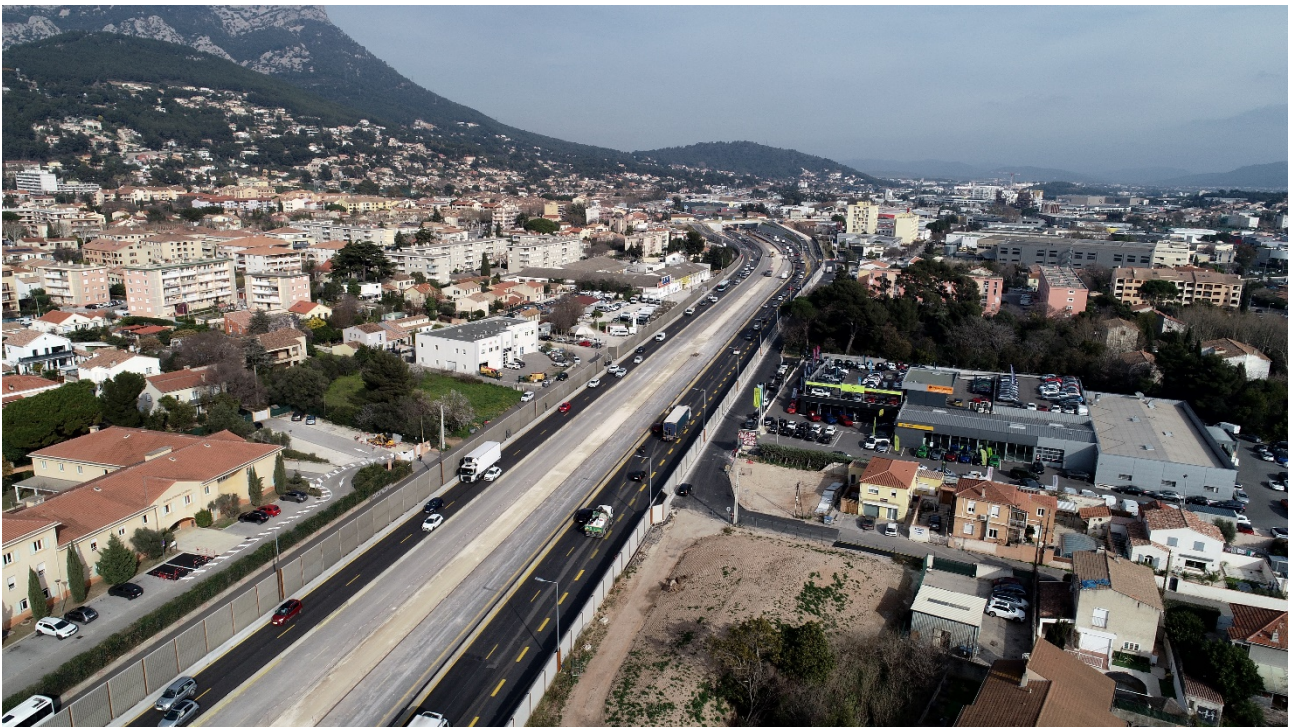
Elargissement A57 - Février 2024 - Création de la 3 e voie dans le terre-plein central de l'autoroute / Secteur de la Coupiane Photo Elite Drone
