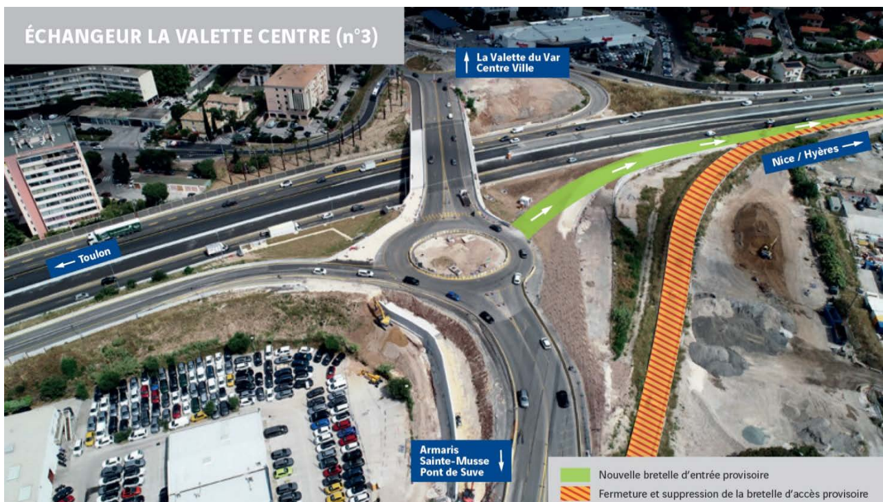
Élargissement A57 – Nouvelle condition d'entrée sur l'autoroute en direction de Nice/Hyères
